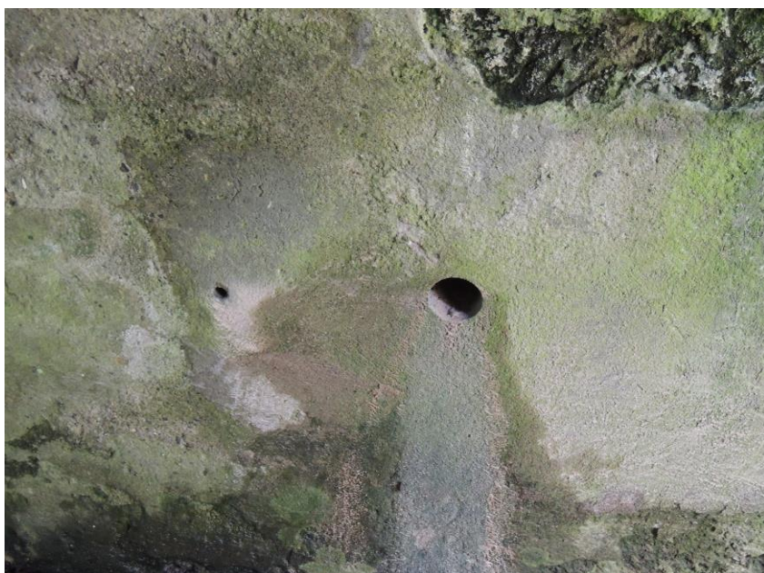
Sondovací vrt pro zjištění tloušťky a složení levé opěry
