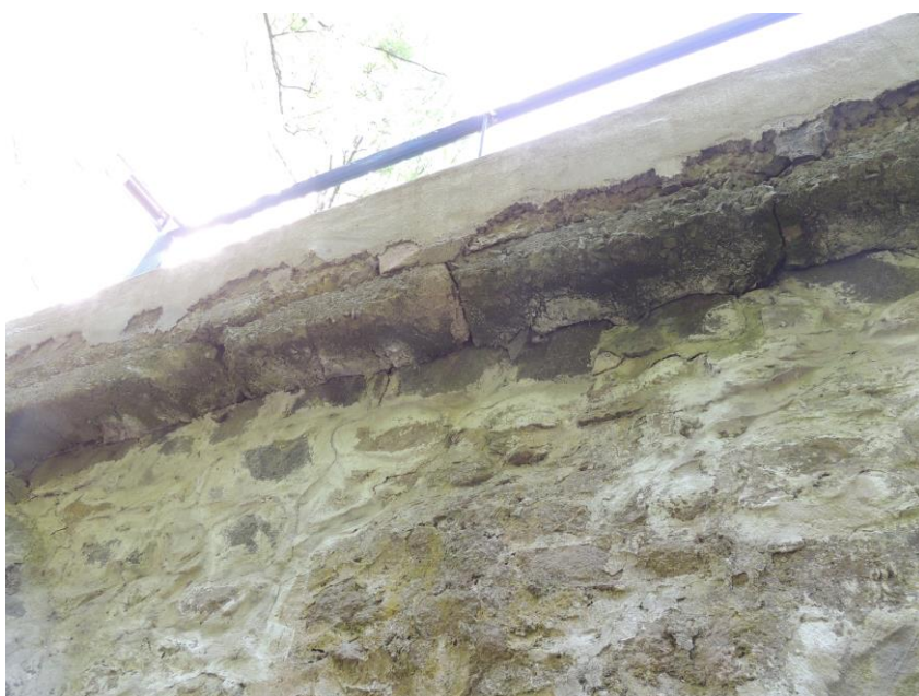
Římsa nad vtokovou částí mostu
